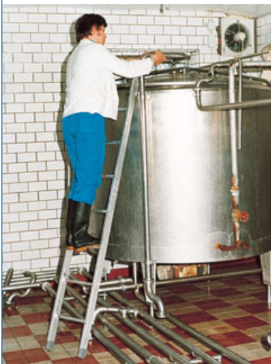
Bild: 31. Leiter mit Einhängenvorrichtung am Behälter
